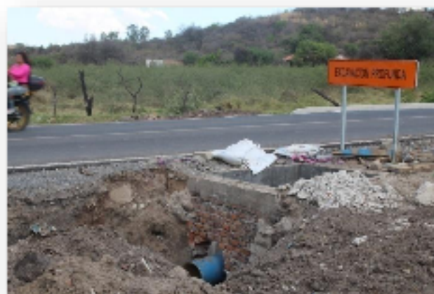
Fotografía 3. Tomada el 09 de mayo de 2020: Obra en proceso en descarga residual clandestina donde se emitieron medidas cautelares
